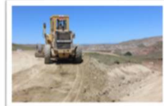
İmar Yollarının Açılması Çalışmaları
